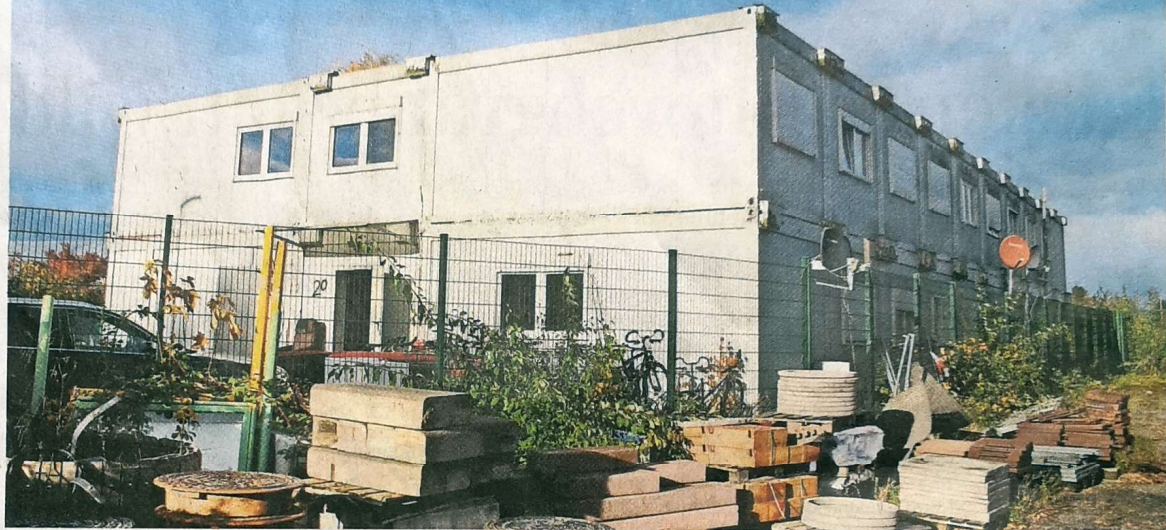
An der Brunnenstraße in Ruit befindet sich die älteste Unterkunft für Geflüchtete in Ostfildern.
